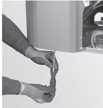
Fig. 70 Verschraubung aufdrehen
