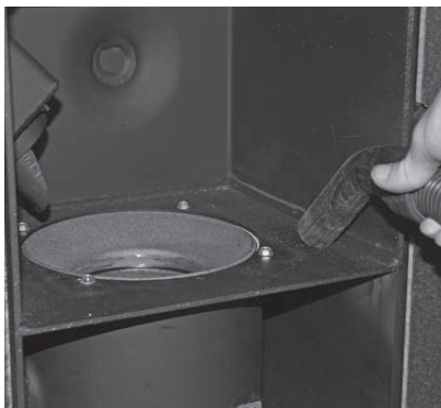
Fig. 42 Verbrennungsrückstände aus dem Brennraum entfernen
