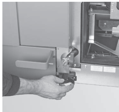
Fig. 35 Spannbügelverschluss öffnen
